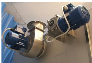
Wentylator wyciągowy i napęd posuwu dysz
